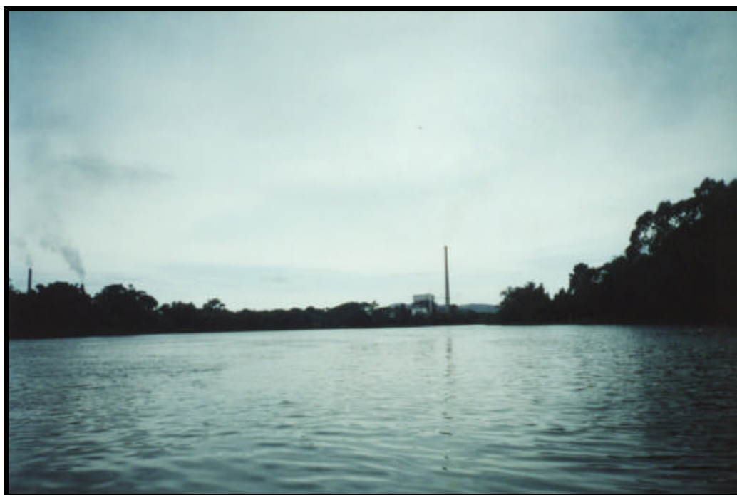
Foto 3.4.1 – Vista do rio Tubarão, sentido jusante, destacando as chaminés da termoeletrica ELETROSUL, situada nas margens da confluência dos rios Tubarão e Capivari.
