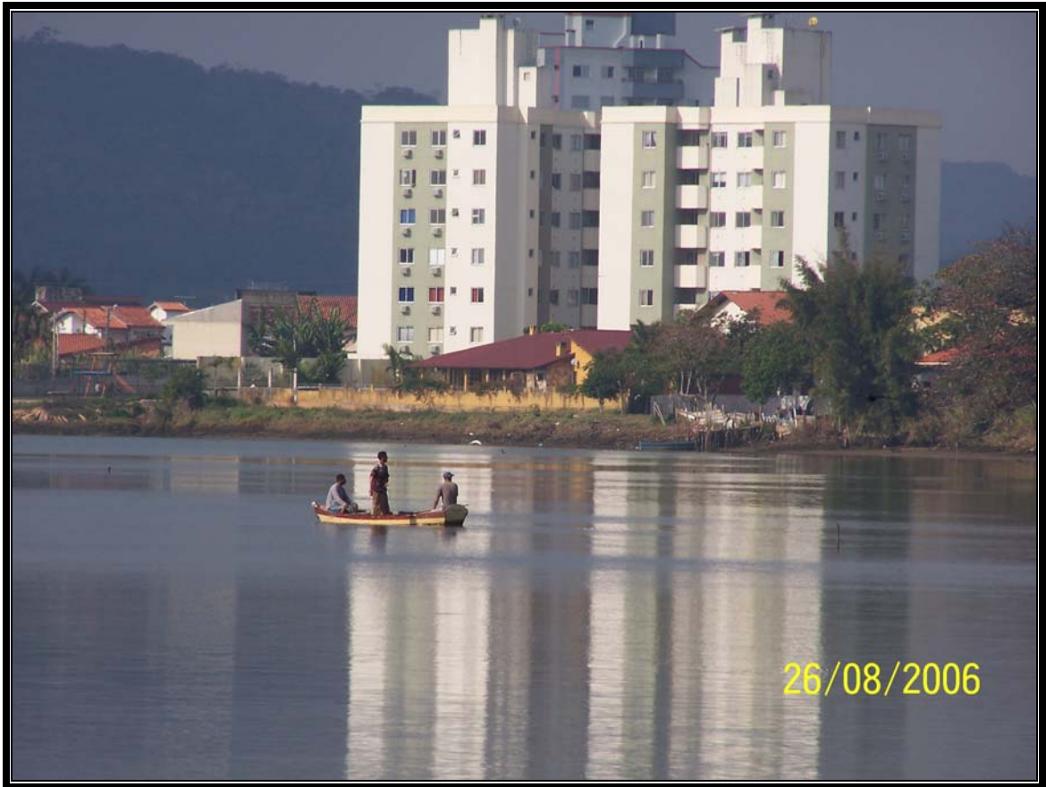
Figura 26 – Imóveis edificados em Área de Preservação Permanente (APP).
